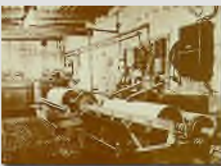
Aufkupperungs Anlagen für Walzen 1953
